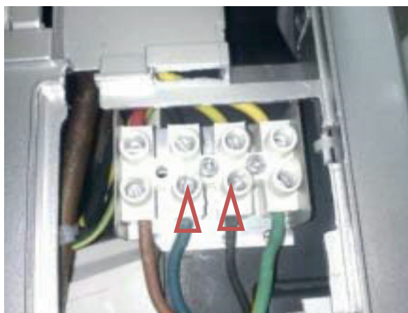
Рис. 1 Проверьте напряжение между клеммами N и S: имеется ли чередование положительного и отрицательного значений?
